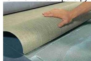
Клей для второй половины полосы должен точно подходить к границе клея на первой ее половине. Вначале наклеивают те половины, которые подходят вплотную к границам помещения: порогам, дверным коробкам и т.п. Полосы укладывают на клей с учетом указанного в инструкции времени схватывания. При укладке на клей нельзя допускать образования воздушных пузырей. Оставшиеся под покрытием пустоты можно определить, постукивая по его поверхности молотком; в этих местах покрытие можно проколоть, чтобы
