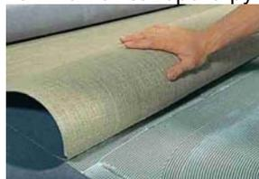
Клей для второй половины полосы должен точно подходить к границе клея на первой ее половине. Вначале наклеивают те половины, которые подходят вплотную к границам помещения: порогам, дверным коробкам и т.п. Полосы укладывают на клей с учетом указанного в инструкции времени схватывания. При укладке на клей нельзя допускать образования воздушных пузырей. Оставшиеся под покрытием пустоты можно определить, постукивая по его поверхности молотком; в этих местах покрытие можно проколоть, чтобы
