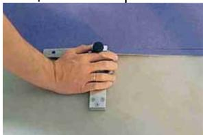
Вторую кромку можно обрезать также кромочным ножом, положив рулоны внахлест. В больших помещениях после нанесения клея кромка верхнего материала размечается специальным комбизаметчиком вдоль уже приклеенного материала и дорезается крючкообразным ножом.
